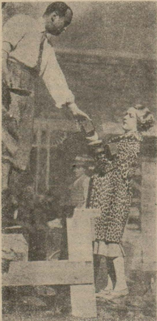
Eski bir hatıra: Douglas duvar örür, Mary tuğla taşıırken
