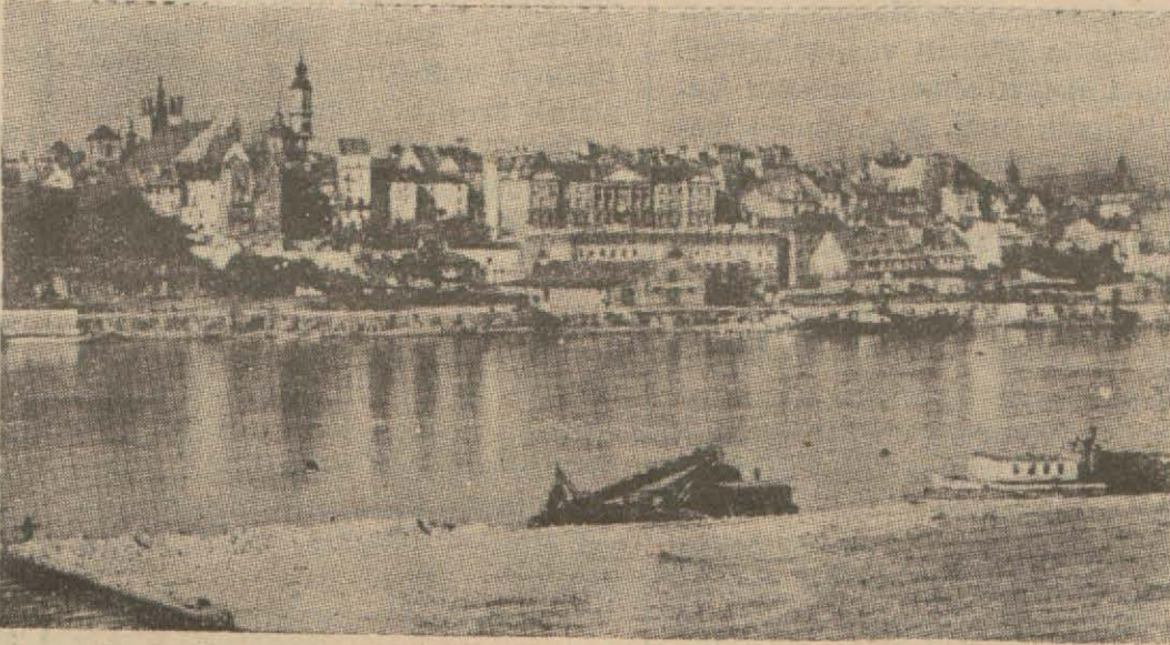
Vistül nehri üzerinden Varşovanın görünüşü
