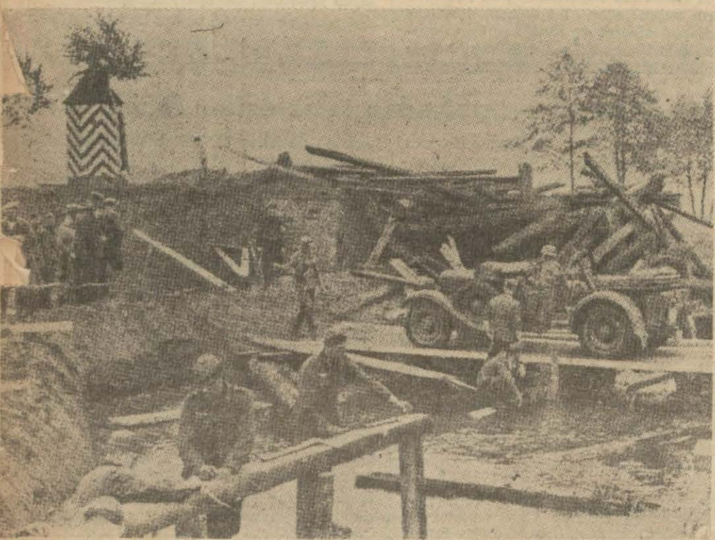
Almanlar yıkılan bir köprü yerine muvakkat bir köprü yapıyorlar
