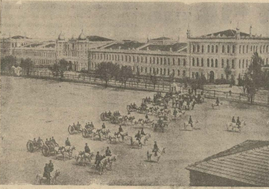
Eski Topçu kışlası Talimhane meydanı
