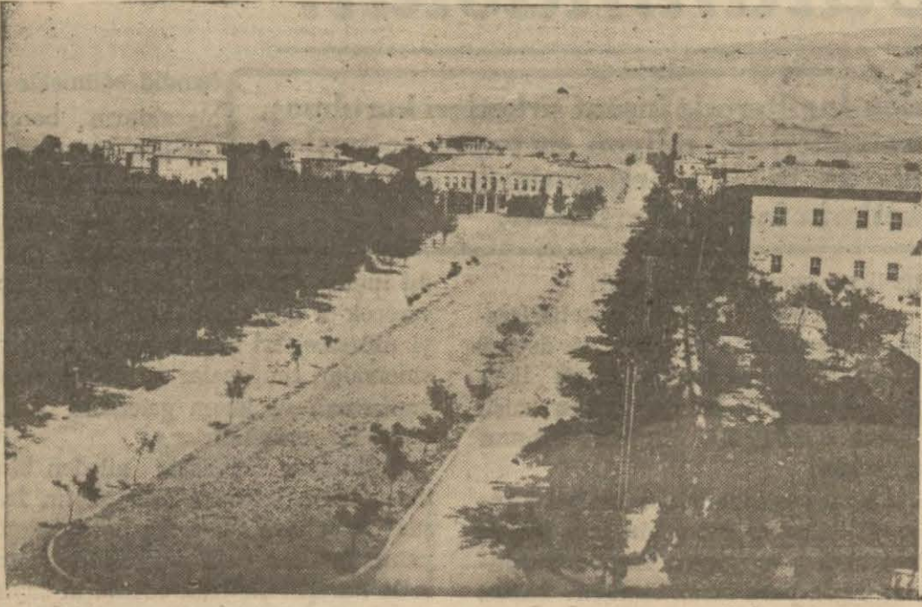
Malatyada istasyon binası ve yeni inşaat
