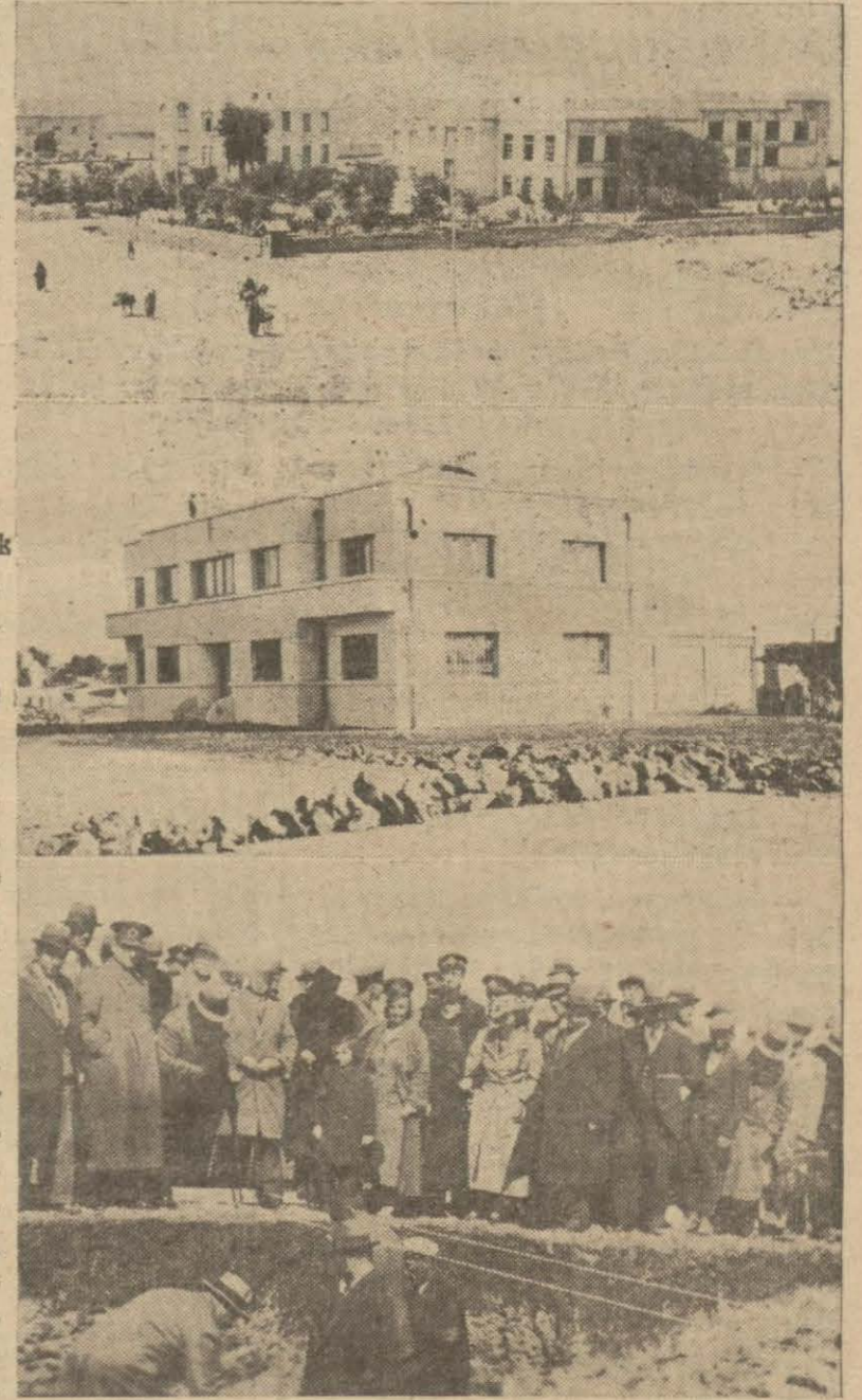
Yukarıda Diyaribekirde Dağ kapısı haricinde yapılan binalardan Orduevi, Halkevi, Vali konağı, ortada yeni binalardan Nafia dairesi, aşağıda Müfettişi umumîlik dairesinin temel atma resmi
