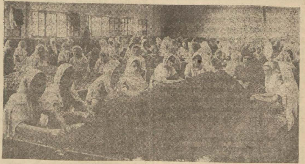
Izmirde bir üzüm işleme yeri
