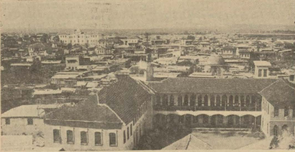
Adananın umumî görünüşü
