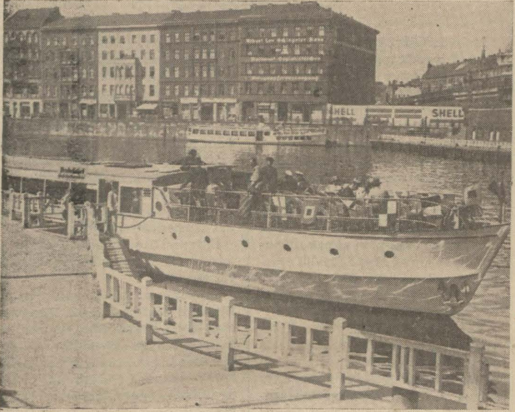
Almanya'da odun ve odun kömürü ile hareket eden bir motörbot yapılmıştır. Yukarıda bu motörbot görünüyor
