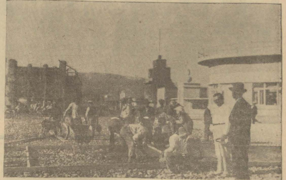
Fuar yollarına asfalt dökülüyor.
