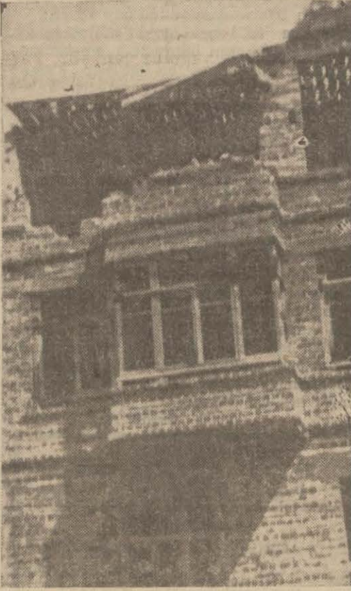
Üst katı yıkılan bina
