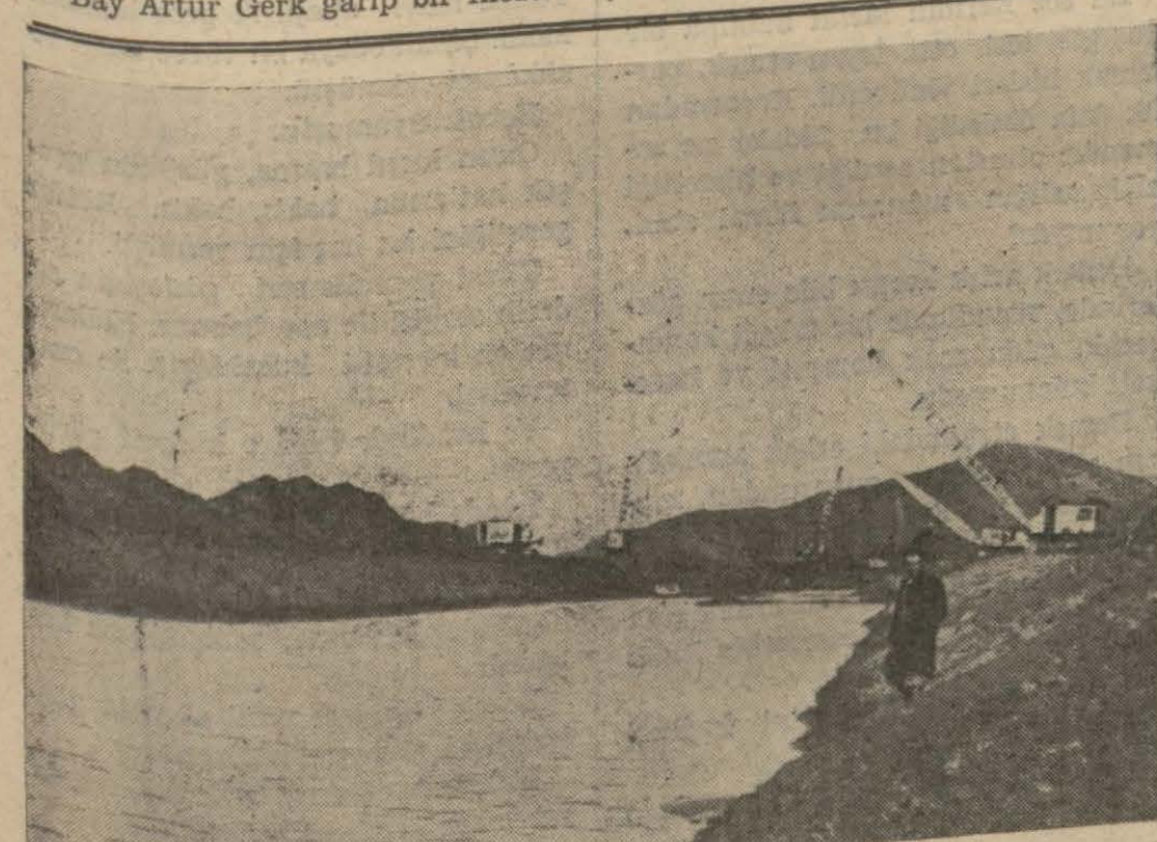
Küçük Menderes nehrinin ıslahı ve Cellâd gölünün kurutulması işine devam ediliyor. Resmimizde Cellâd gölünün sularını denize akıtan kanal ve hafriyat yapan makineler görünüyor.
