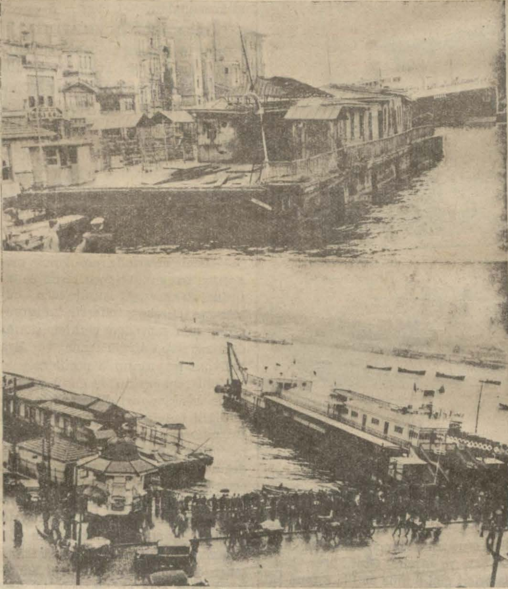
Yukarıda Kadıköyün sökülen eski iskelesi aşağıda eski ve yeni iskele yanyana
