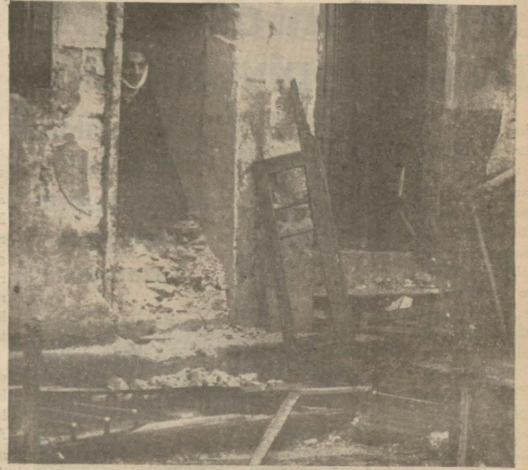
Tramvayın çarptığı apartımanda yıkılan duvar
