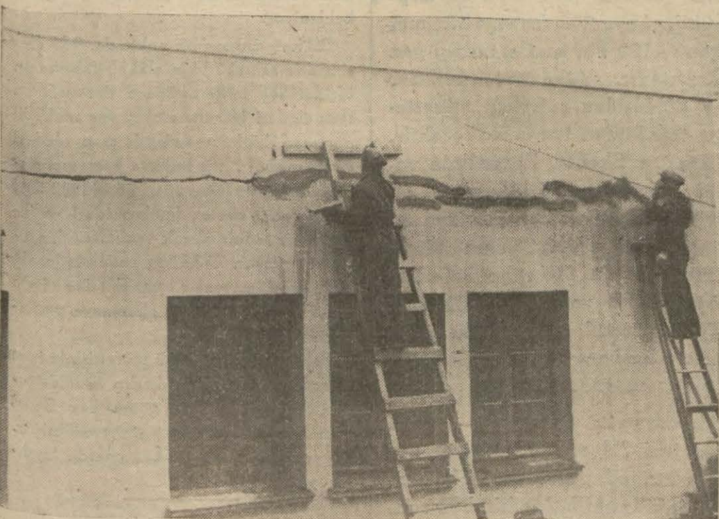
Hâl duvarında görülen çatlaklık dolduruluyor
