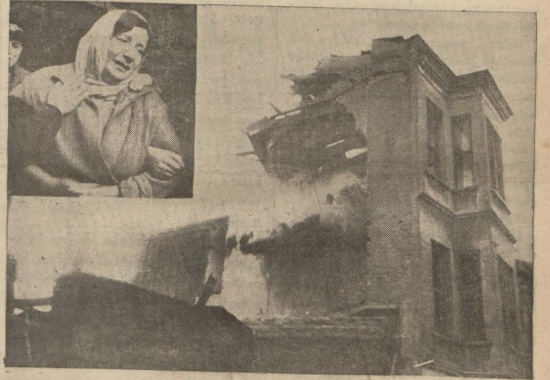
Yıkılan ev ve kiracı Eleni
