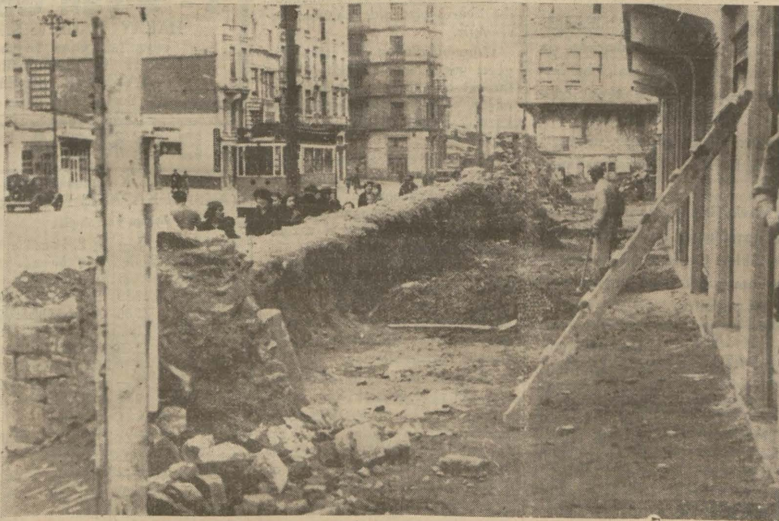
Şişli caddesinde yaya kaldırımlarının genişletilmesine başlanmıştır. Yukarıki kışımız, kaldırımları genişletmek için yapılan hafriyatı gösteriyor.
