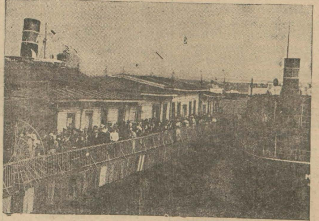
Köprüdeki Kadıköy Iskelesi
