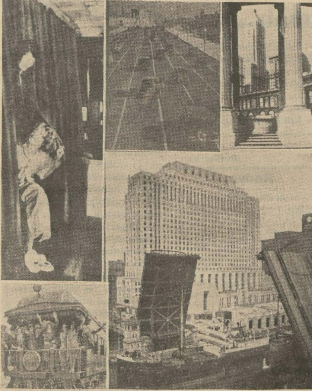
Yukarıda sağda: Şikagoda yeni yapılan yüksek binalardan biri: Pittsfield Building - Ortada: Mişigan avenüde caddenin otomobillere ayrılmış geniş kısmı - Solda: Şikagoya giderken vagonumuzun yataklı vagon haline getirilen bir köşesi - Aşağıda sağda: Şikago nehri üzerindeki köprülerden biri bir gemi geçsin diye açılmış, arkadaki büyük bina Daily News gazetesi matbaa ve idarehanesidir - Solda: Amerika trenlerinin arkasındaki geniş balkon ve yolculardan bir grud
