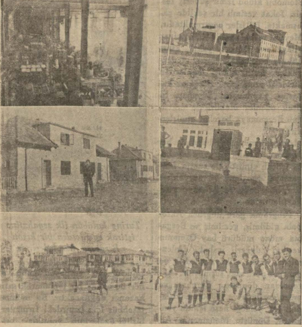
Yukarıda fabrikanın dışardan görünüşü ve iç manzarası, ortada memur evleri ve sinema, aşağıda eski Turhal ve şeker fabrikası futbol takımı
