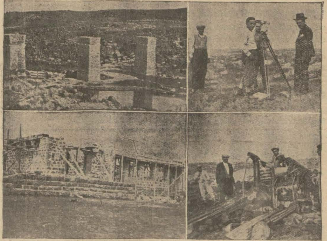
Fevzipaşa - Diyarıbekir hattının yapılmasına aid birkaç resim
