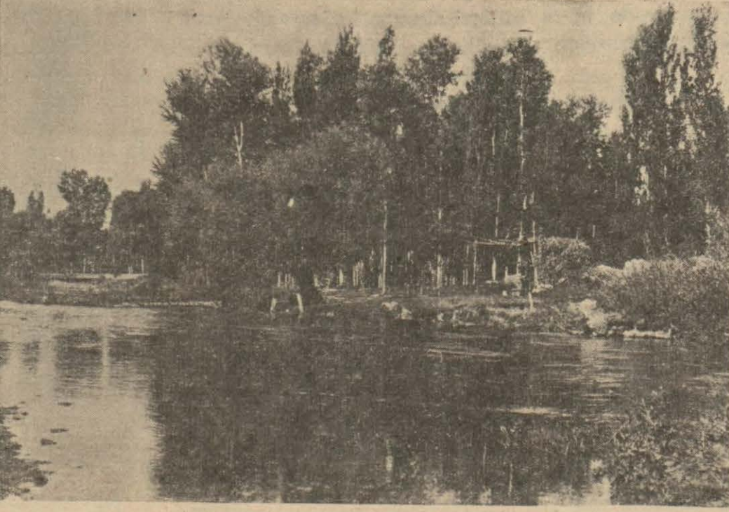
Yeşil Aksaraydan bir görünüş ve sinema binası yapılması için çalışılmaktadır.
