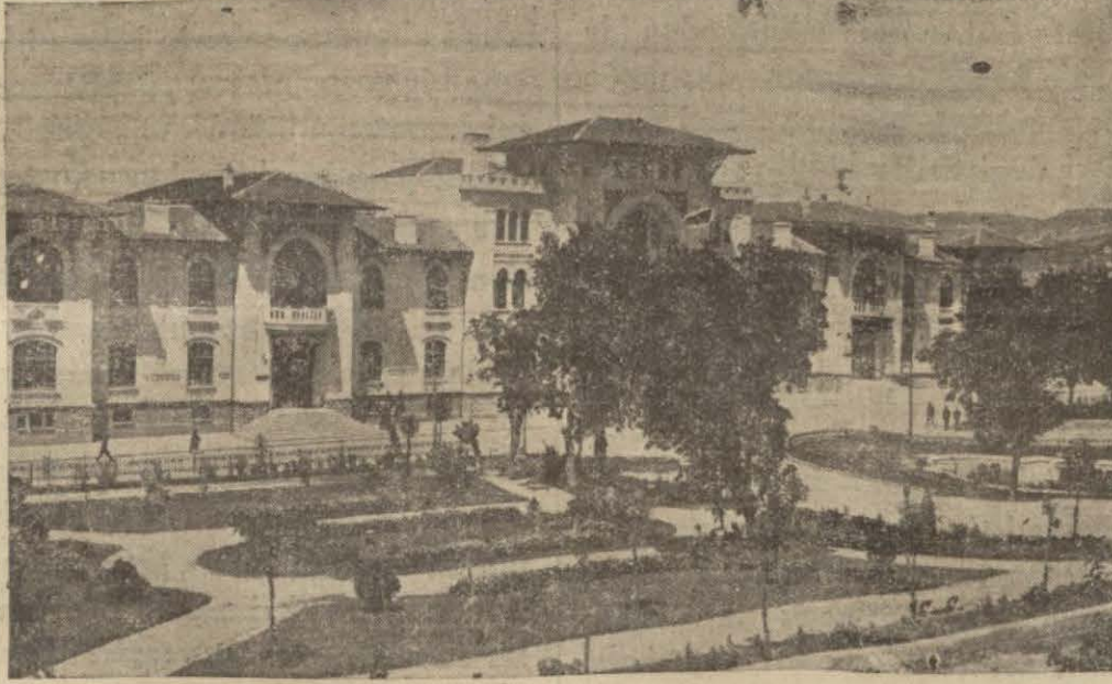
Maliye vekâleti binası
