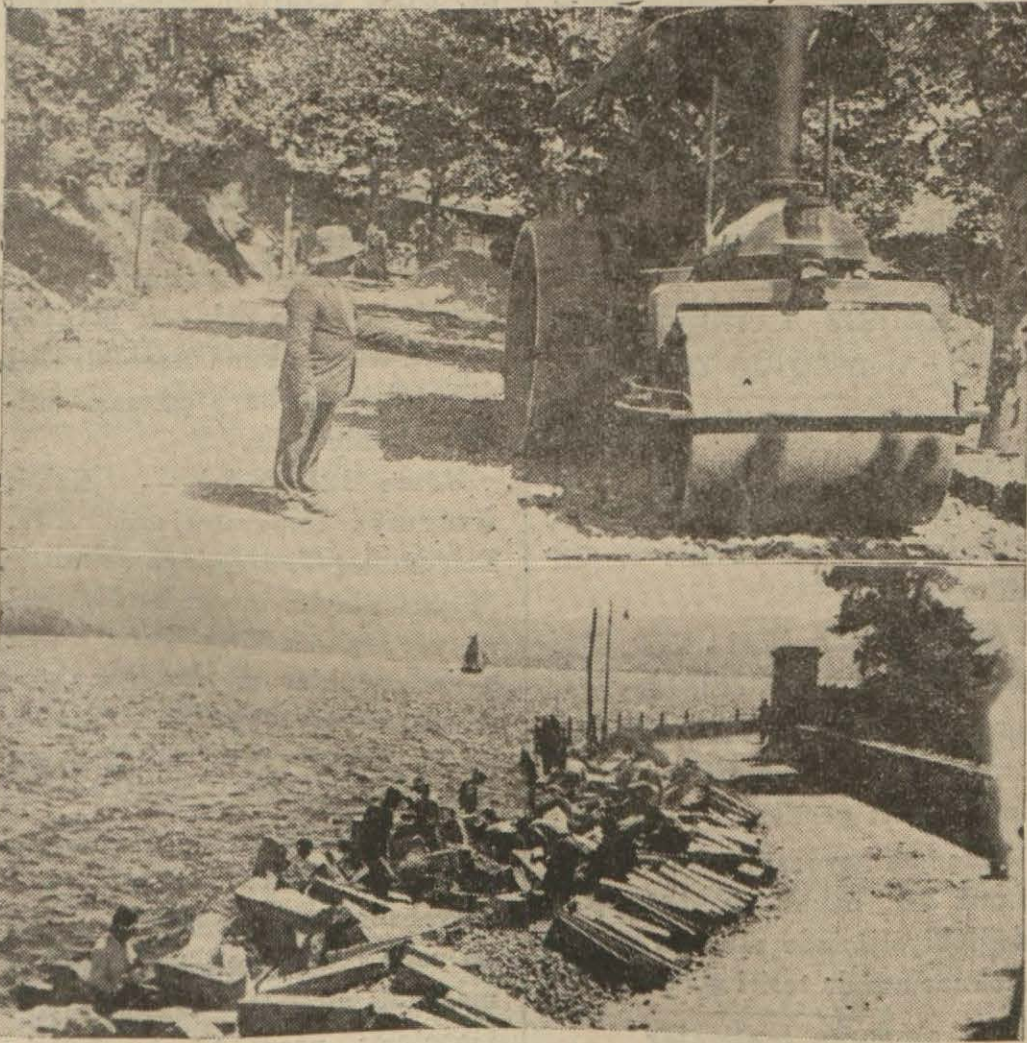
Yukarıda: Çimento ile yapılmakta olan Haciosman bayırı - Tarabya yolu tesviye ediliyor, aşağıda: Rumeli sahilinde tamir edilen rıhtımlar
